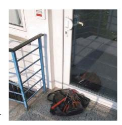
Nutze. Die normalen Öffnungs- und Verschlussvorrichtungen sind sehr häufig so nachgiebig ausgebildet, dass ein Einbrecher nicht mehr als ein paar Sekunden benötigt, um die Terrassentür oder das Fenster zu öffnen.
