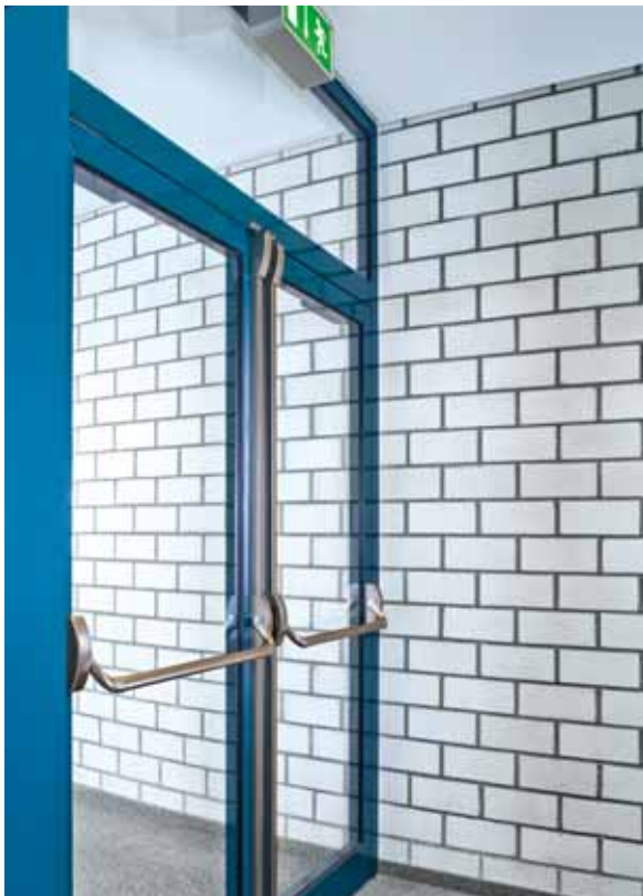
Bild 6-11: Druckbügel eines Panikverschlusses
