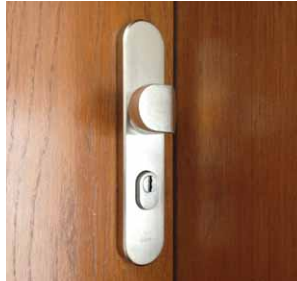
Bild 6-5: Türschild mit Kernziehschutz-Rosette
