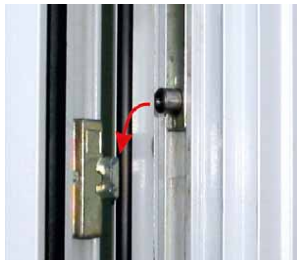
Bild 8-3: Rollzapfenbeschlag
