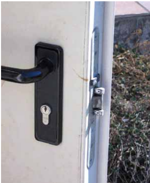
Bild 6-8: Notausgangsschloss, schwache Ausführung
