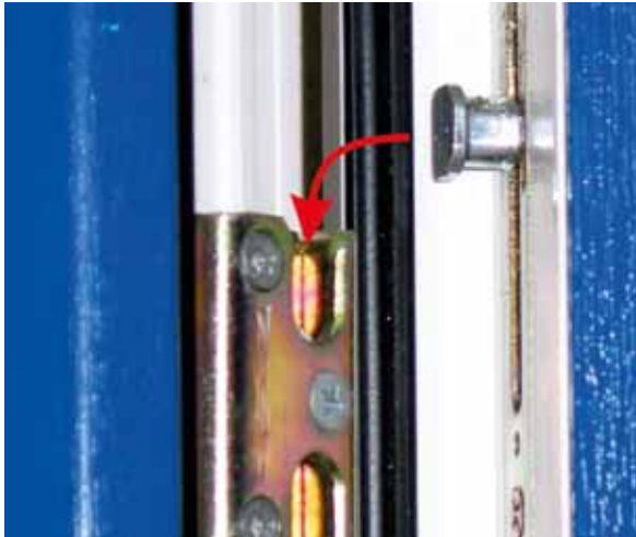
Bild 8-4: Pilzkopfbeschlag
