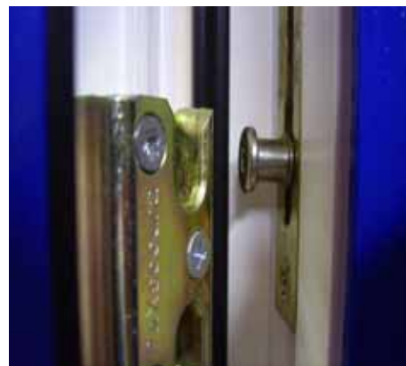
Bild 5 Runder Zapfen im mit Einschlussblech
