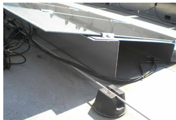
Bild 18: Abstand zwischen DC-Leitungen und Blitzschutzanlage nicht eingehalten (Trennungsabstand)
