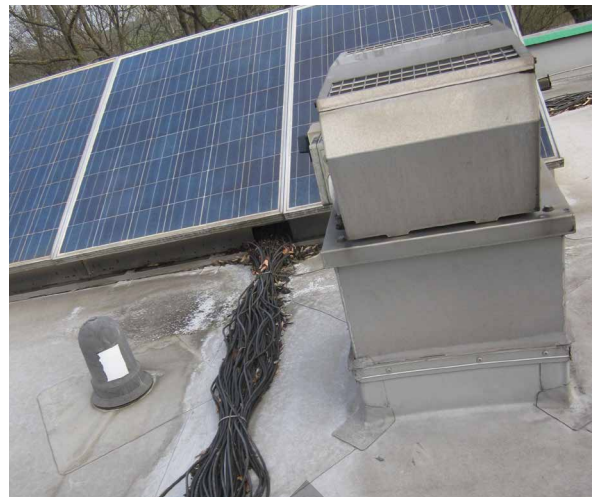
Bild 13: nicht fachgerechte Leitungsverlegung
