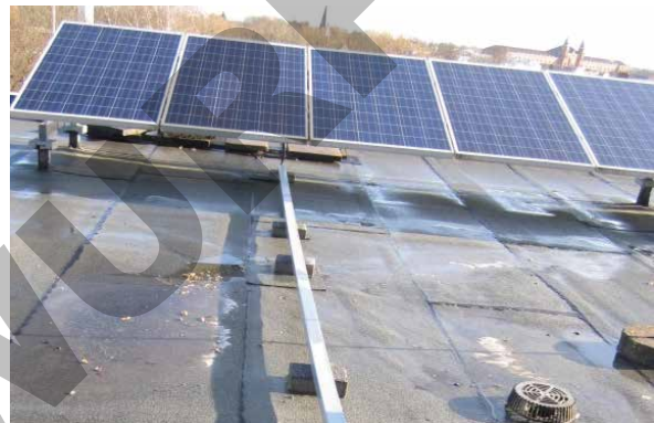
Bild 13: nicht fachgerechte Leitungsverlegung
