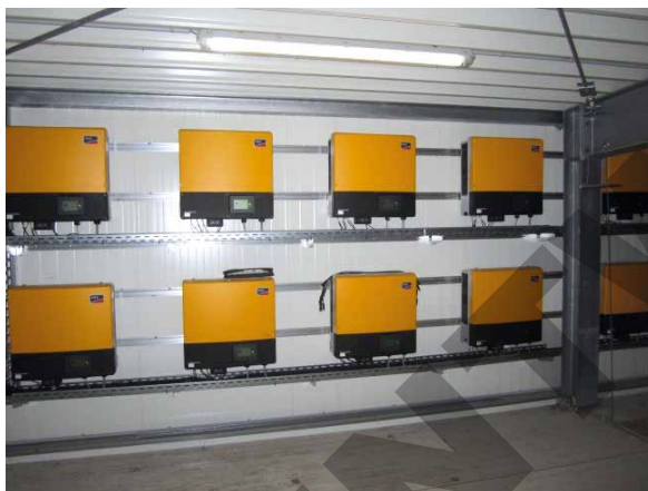
Bild 9: Wechselrichter auf nichtbrennbaren Untergrund
