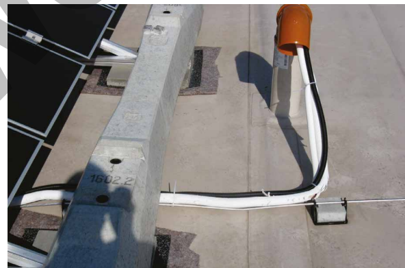
Bild 17: Abstand zwischen DC-Leitungen und Blitzschutzanlage nicht eingehalten (Trennungsabstand)
